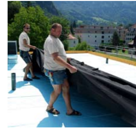
Bild A: Hertalan Plane 1,3 mm, lose verlegt mit Auflast
